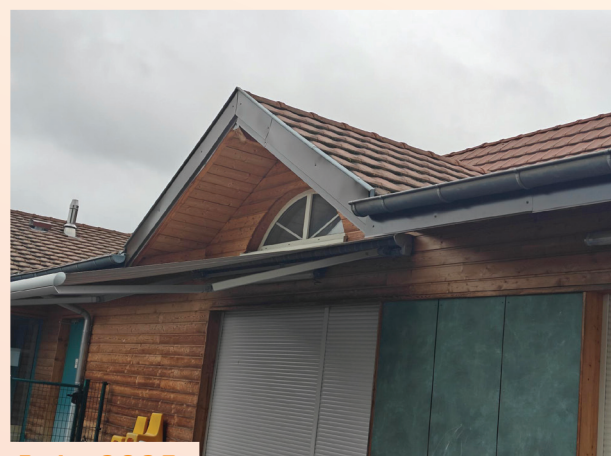
Juin 2025 Travaux de bardage du Multi-accueil
